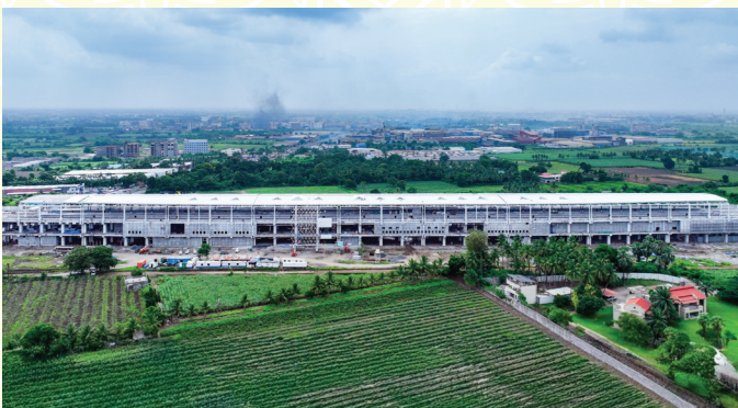
निर्माणाधीन सूरत बुलेट ट्रेन स्टेशन
